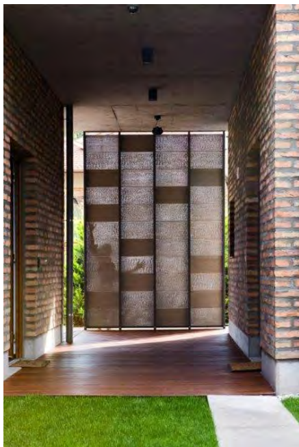
Figur 13 - Gennemskinnelig beton som læskærm
