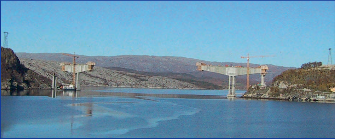
Sundøy Bro, Norge - Fri frembygning med langt spænd
